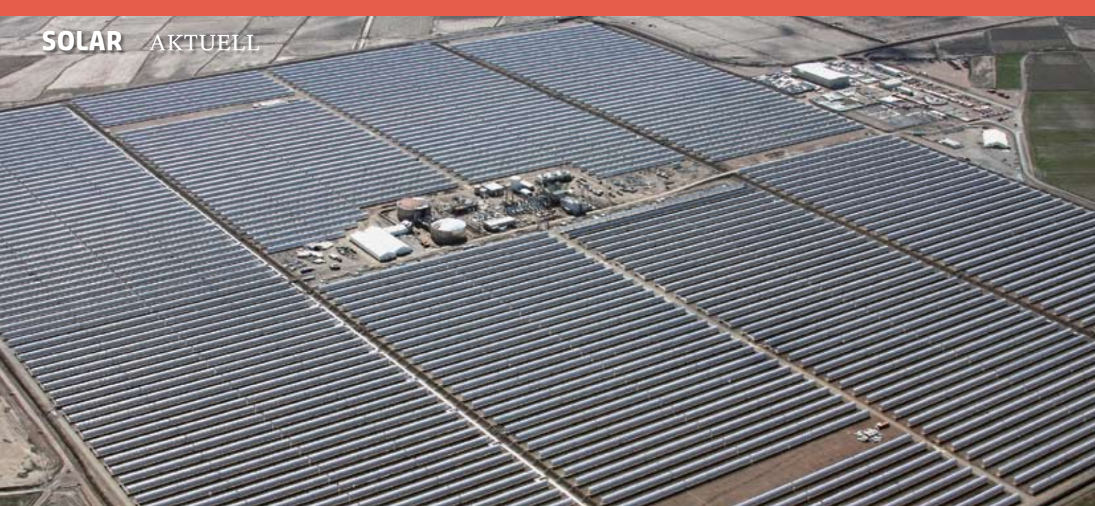
Auf 2 km 2 bündeln 624 Kollektoreinheiten die Kraft der Sonne und transportieren sie ins Zentrum der Anlage. Foto: Solar Millennium
