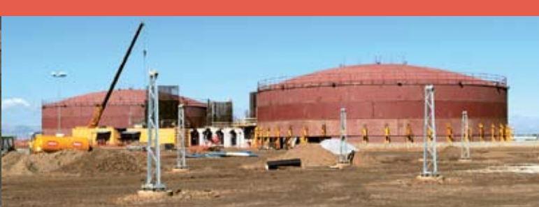
28.500 t Flüssigsalz als Wärmespeicher. In der Nacht geben die Tanks Wärme ab und ermöglichen eine Stromproduktion über die Dauer von 7,5 h. Foto: Solar Millennium
