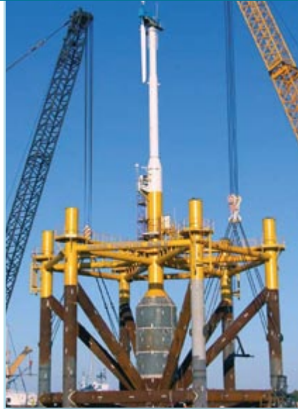
Abb. 3: Das TLP-Konzept von Blue H Technologies. Quelle: Blue H Technologies
